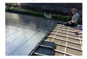
La tuile photovoltaïque **Cerasolpan**® est une alternative aux modules traditionnels.
