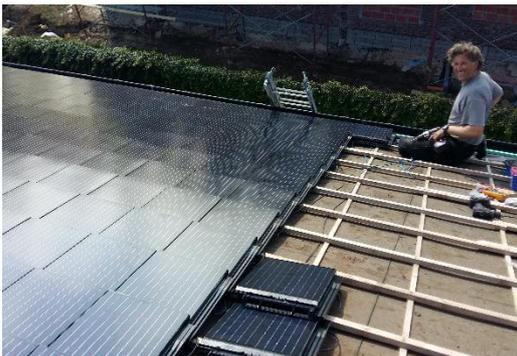
La tuile photovoltaïque **Cerasolpan®** est une alternative aux modules traditionnels.
