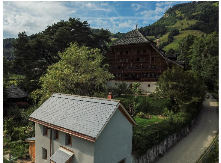
Ziegel | Tuile : Solaris Heritage, SPower 3. Oberfläche | Surface : 54 m 2 , 8 kWp
